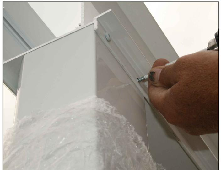
Legen Sie die Rinne und die Pfosten entsprechend aneinander, bohren Sie mit einem Metallbohrer 4mm vor und verschrauben Sie dann die Bauteile mit jeweils 2 Karosserieschrauben (C101-025).
