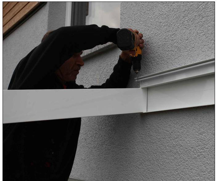
Bohren Sie die Schraublöcher mit einem 4mm Metallbohrer vor und verschrauben Sie die Sparren mit jeweils einer Karoserieschraube (C101-025) an den beiden Pfetten.
