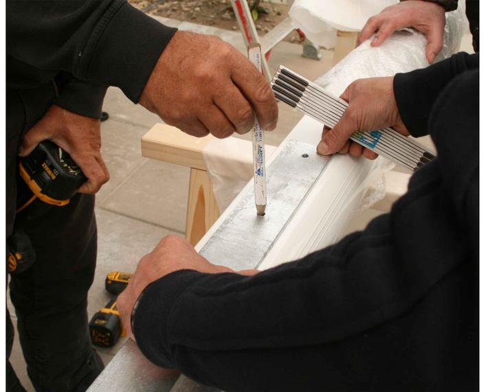
Zeichnen Sie die mit Gewinde vorgebohrten Schraublöcher der einzelnen Pfostenlaschen an die jeweiligen Pfosten an. Bohren Sie mit einem 9mm Metallbohrer vor und schieben Sie die Laschen in den entsprechenden Pfosten.
